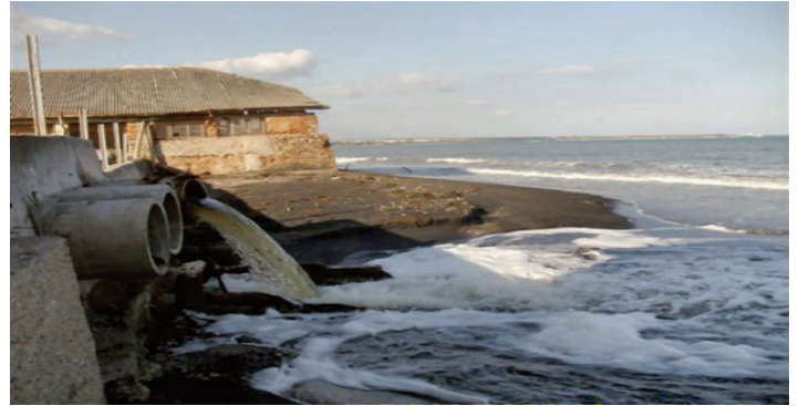
Abwasserrohr einer Meerwasserentsalzungsanlage in Bulgarien
